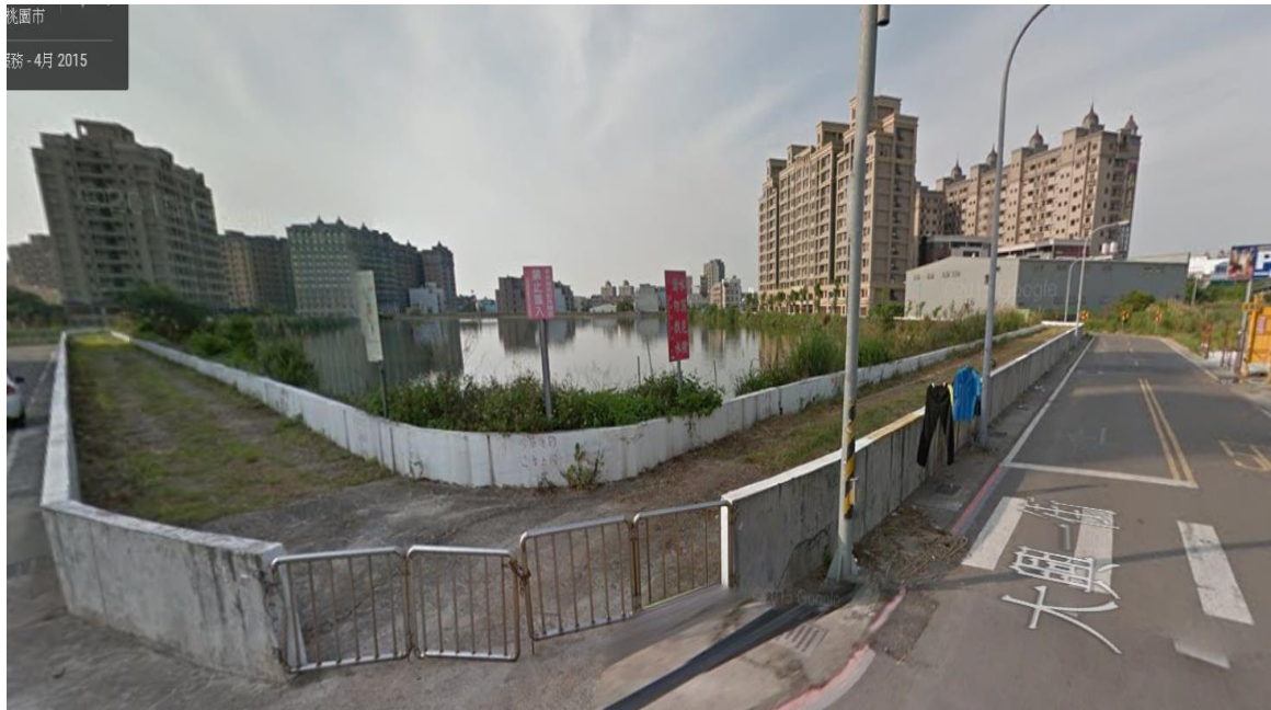
圖四 蘆竹區 2-11 號埤塘現況照片
