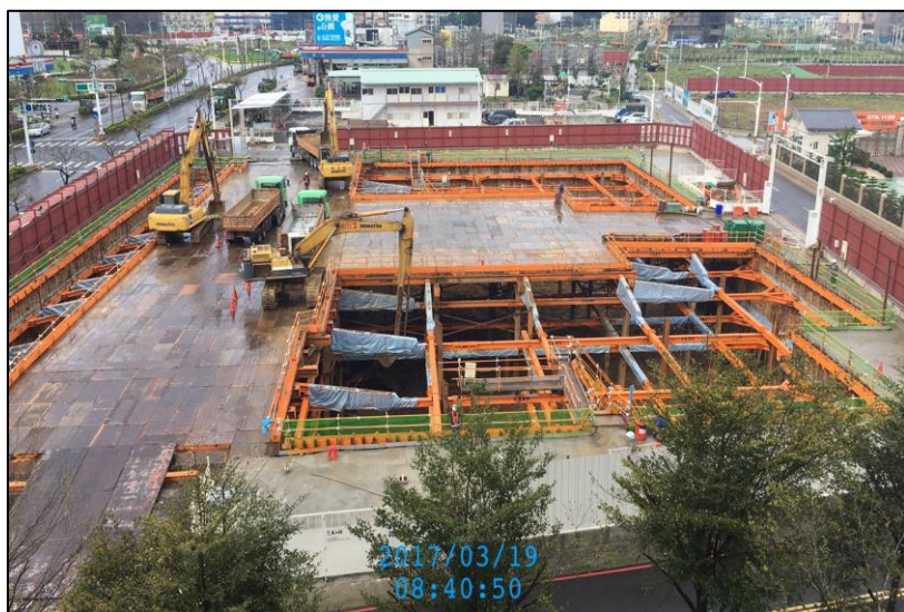
中路二號社會住宅施工現場圖
