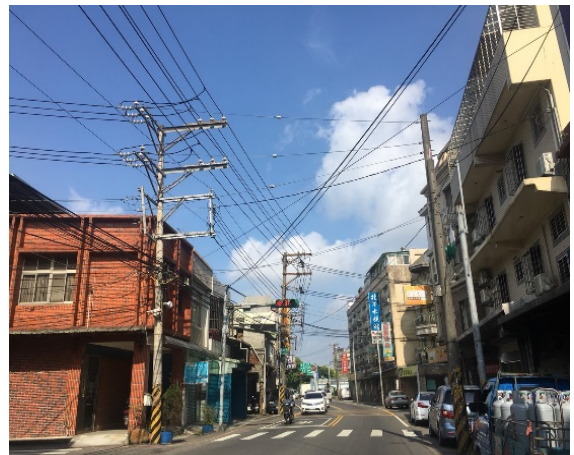
圖五：雜亂電線桿有礙市容，使民眾心裡產生壓力
