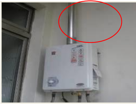
圖 3-12.於熱水器加裝強制排氣管(左)，或改為電熱水器(右)
